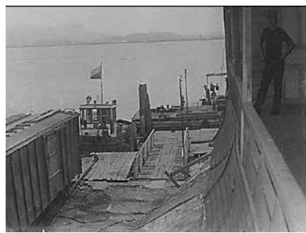
Muelle de carga de la empresa de ferrocarriles .
