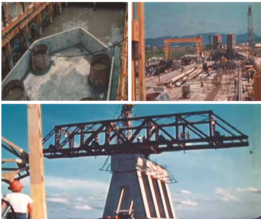
Proceso de ejecución de la obra del Puente de Unidad Nacional por parte del consorcio de firmas italianas.
