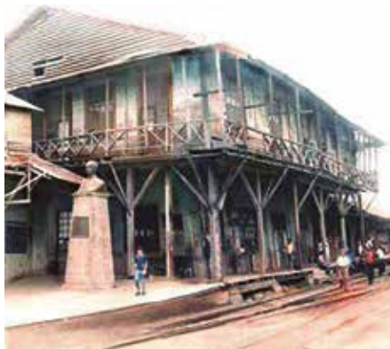
Antigua estación ferroviaria de Durán.
