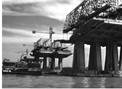
Construcción del Puenete de la Unidad Nacional.
